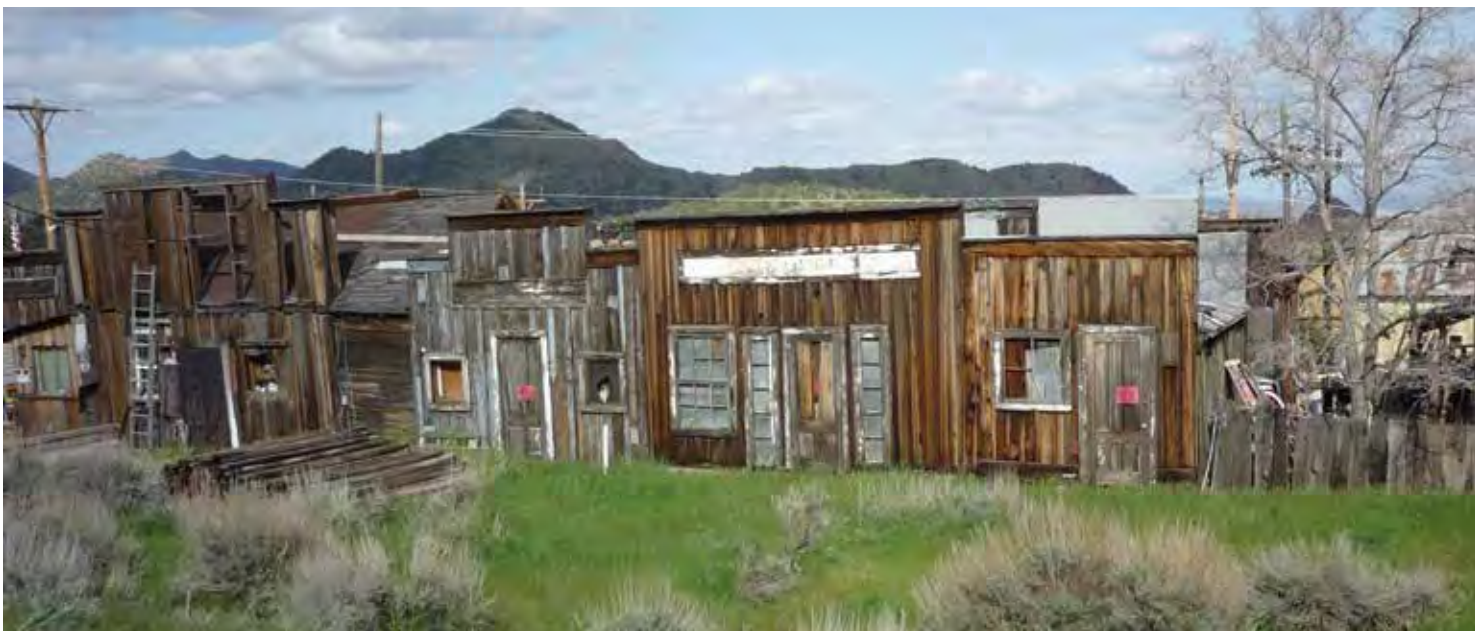
Strutture fatiscenti di Virginia City
